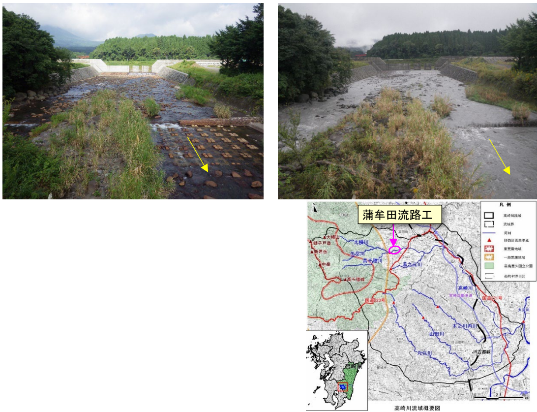
図 3.3 蒲牟田流路工（左：新燃岳噴火前 H29.7、右：新燃岳噴火後 H29.10）
