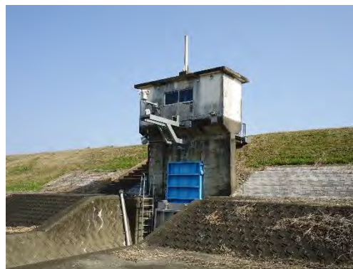
写真 2-1-9 樋管 (持田樋管：小丸川)
