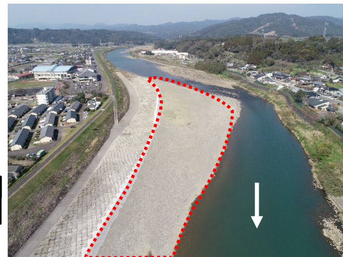
高城橋付近（河道掘削）
