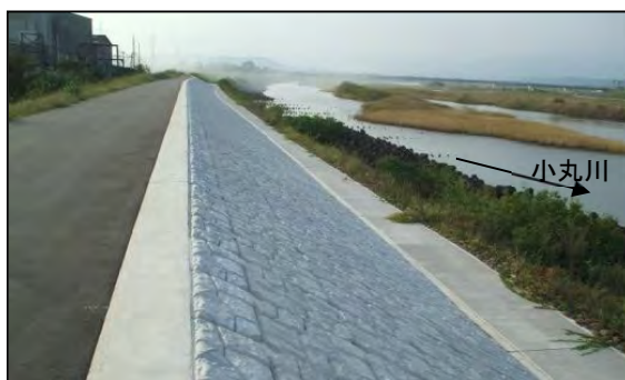
写真 2-1-5 高潮堤防の整備状況 (高鍋町蚊口地区)
