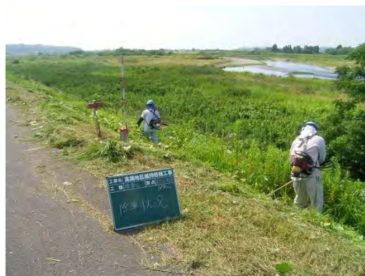
写真 4-3-3 堤防除草作業
