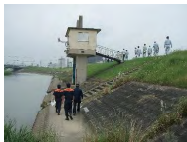
写真 4-3-12 出水期前の合同巡視
