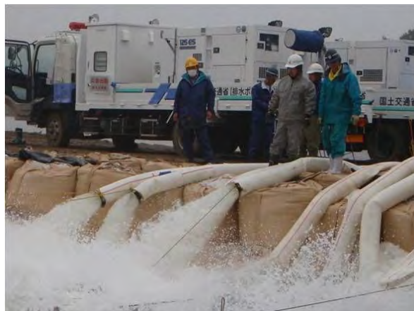
写真 4-3-7 排水ポンプ車による排水活動
