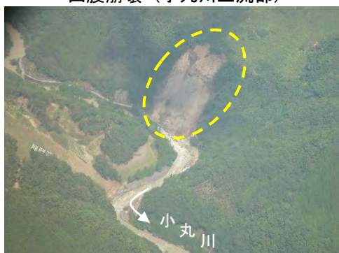
山腹崩壊（小丸川上流部）
