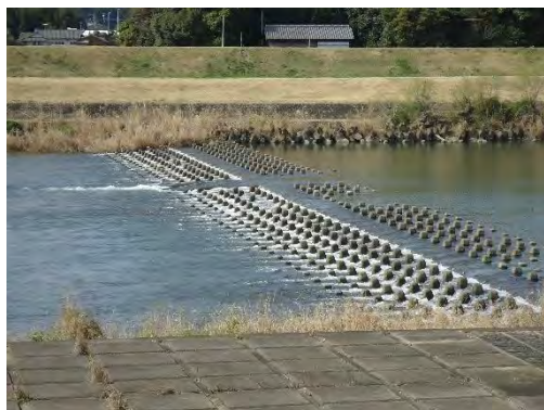
写真 2-1-8 床止め (小丸川床止め：小丸川)
