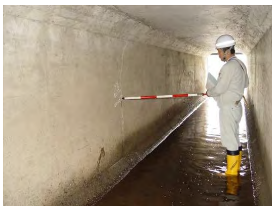
写真 4-3-4 樋門の保守点検
