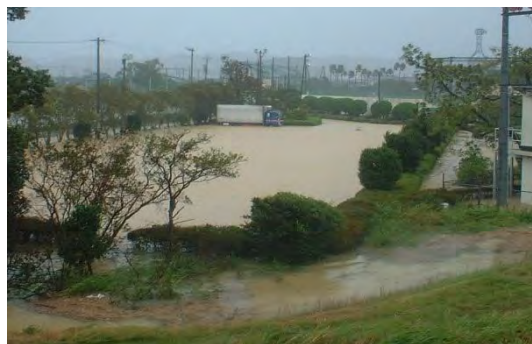
浸水被害状況（高鍋町）
