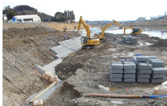
大型張りブロック（築堤護岸工事）
