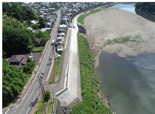
【施工状況：全景】 (令和7年6月)
