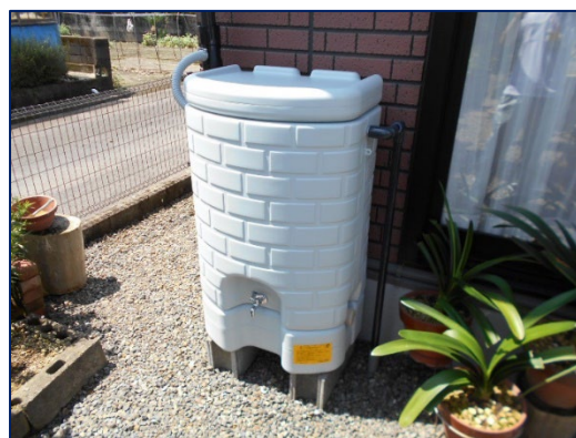
【雨水貯留施設設置例】
