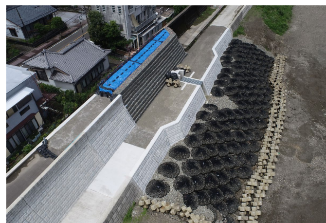
【施工状況：樋管改築】 (令和7年6月) 9
