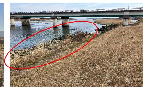
④ 大型ブロックが設置され、水際に安全に近づくための親水施設がない。
