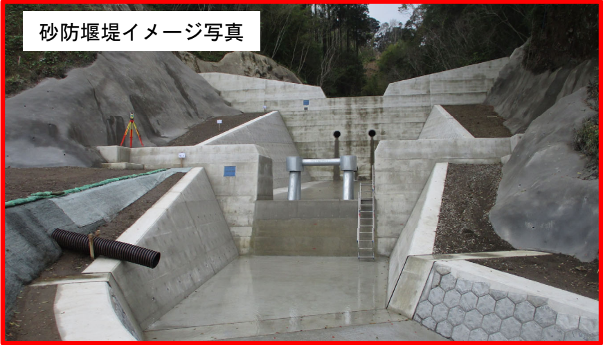
実施箇所：高野谷川他13溪流
