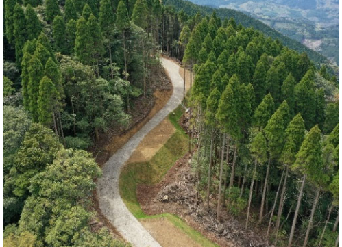
森林整備を行うための林道開設
