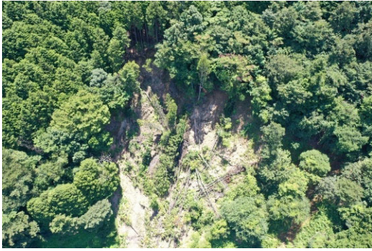
山腹崩壊地の復旧
