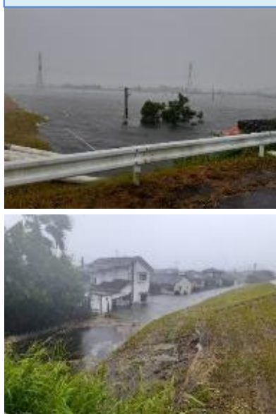
浸水被害の状況
