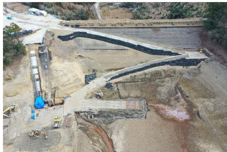
改修工事実施中
