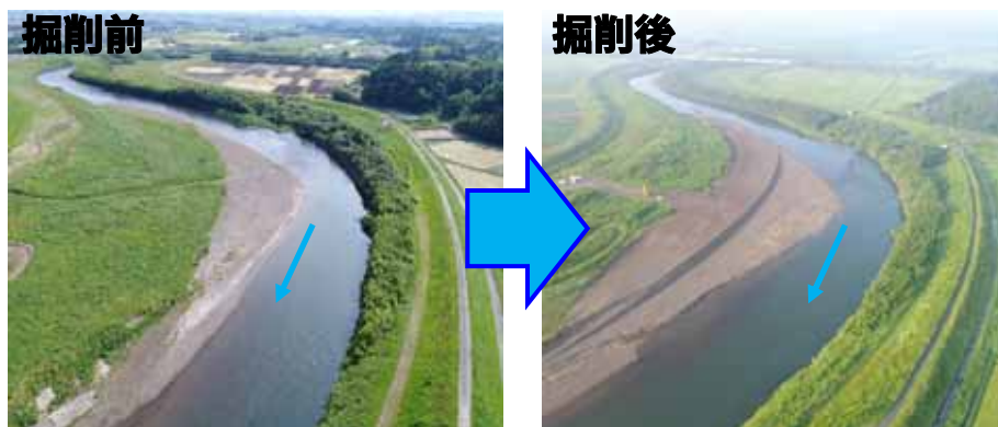
④都城市太郎坊地区 (大淀川65k800付近)
