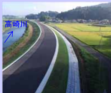
④ 堤防天端の保護
