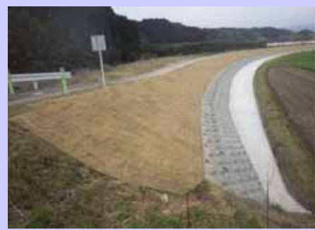
⑤ 堤防裏法尻の補強
