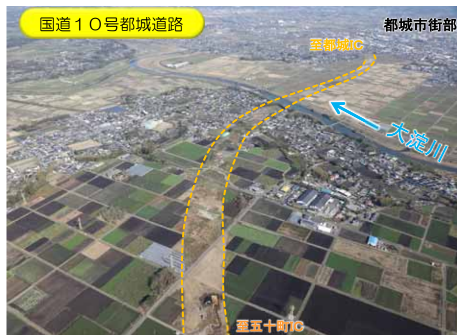
国道10号都城道路の状況（H30撮影）
