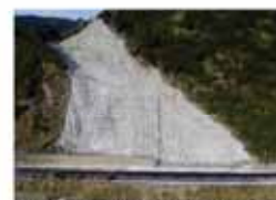
土砂災害等の危険性が高い約2000箇所の道路法面・盛土対策、道路拡幅等
