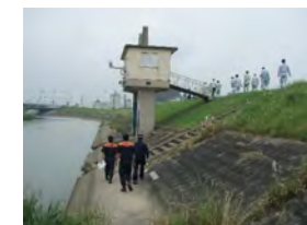
写真 4-3-12 出水期前の合同巡視
