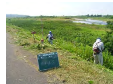
写真 4-3-3 堤防除草作業
