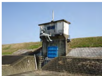
写真 2-1-9 樋管(持田樋管：小丸川)
