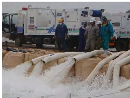
写真 4-3-7 排水ポンプ車による排水活動
