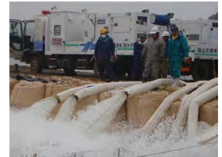
写真 4-3-7 排水ポンプ車による排水活動
