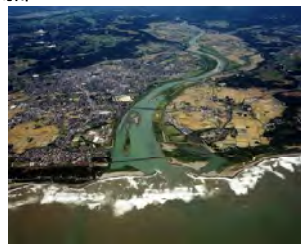
写真 1-1-3 小丸川下流部（河口付近）
