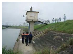
写真 4-3-11 出水期前の合同巡視
