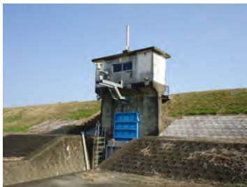
写真 2-1-9 樋管(持田樋管：小丸川)
