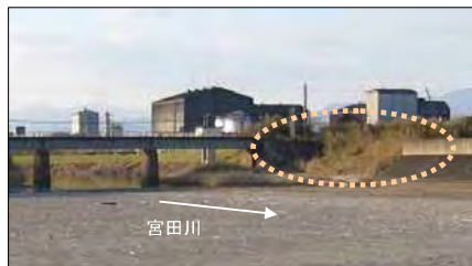
写真 2-1-5 堤防の未整備箇所 (宮田川)
