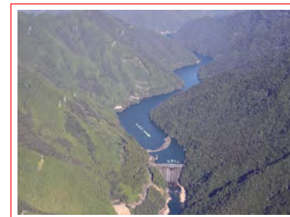
写真 1-1-1 小丸川上流部 (松尾ダム付近)
