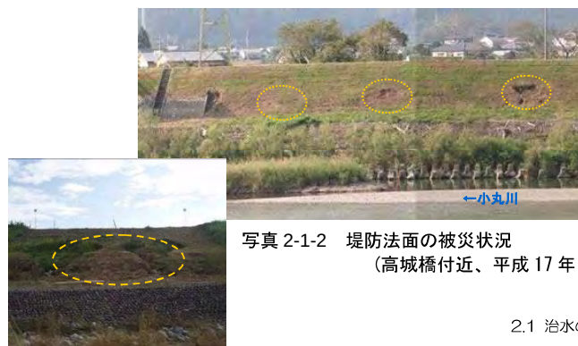
写真 2-1-1 堤防漏水の発生事例 (切原川合流点上流、平成 17 年 9 月洪水)
