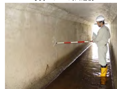
写真 4-3-4 樋門の保守点検
