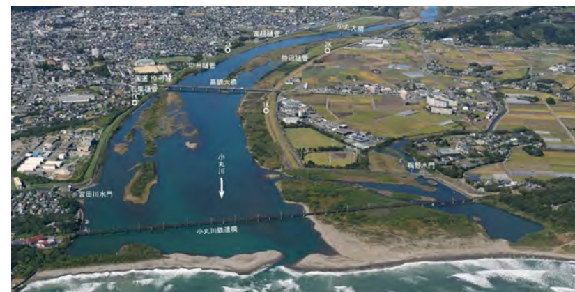
写真 2-2-32 小丸川下流部 (河口付近)
