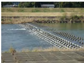
写真 2-1-8 床止め(小丸川床止め：小丸川)
