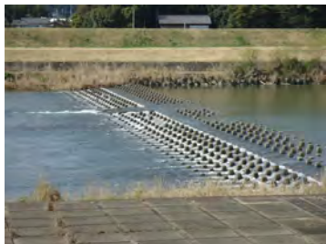
写真 2-1-8 床止め(小丸川床止め：小丸川)
