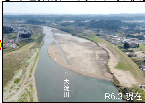
【河道掘削・樹木伐採後】
