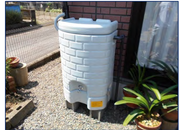
【雨水貯留施設設置例】
