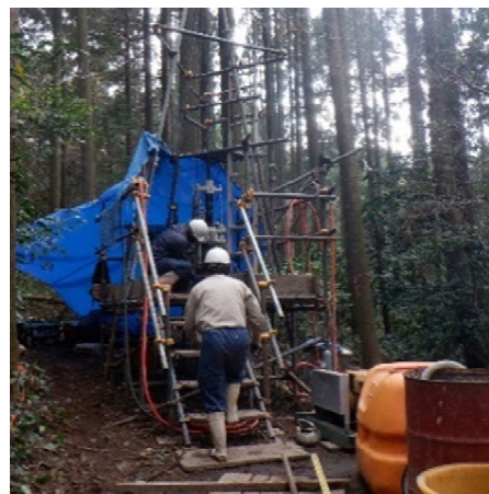
ダム周辺の地質調査状況
