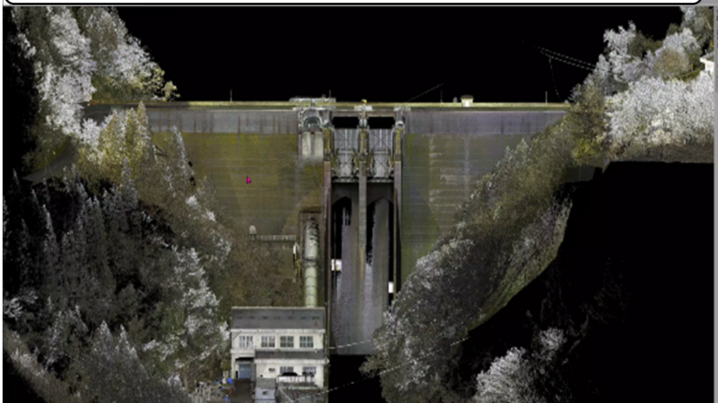
UAV（ドローン）による3D測量（施設図・地形地質判読図）
