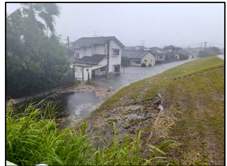
令和4年台風14号都城市浸水状況写真
