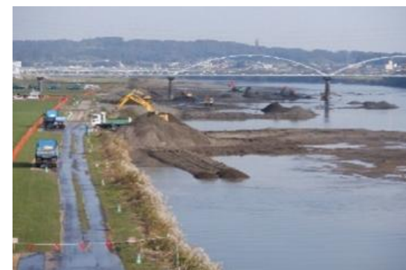
河道内の堆積土を掘削
