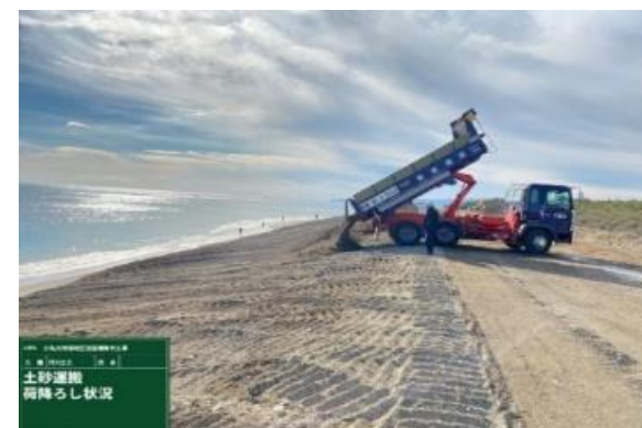
掘削土を海岸養浜に活用
