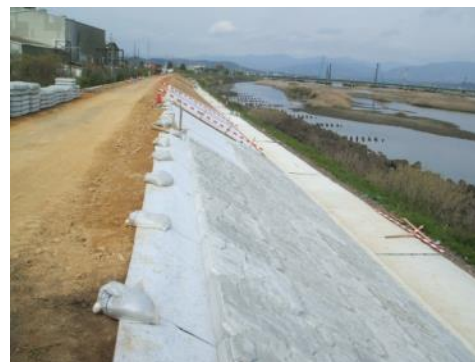
大型張りブロック(小丸川高潮区間)
