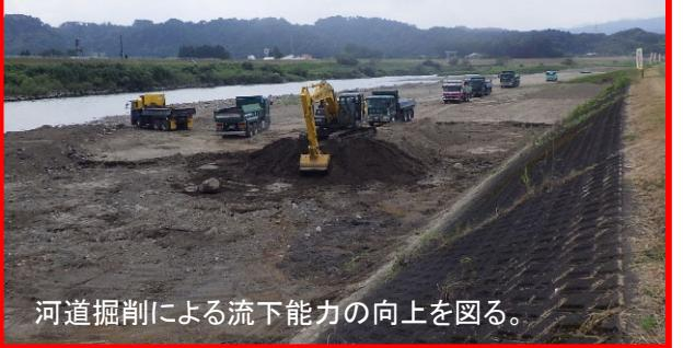
河道掘削による流下能力の向上を図る。
