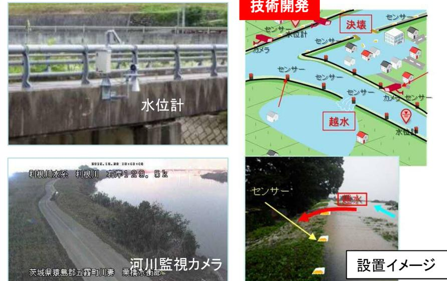
氾濫の危険性が高く、重要施設や人家への影響が大きい箇所への河川監視カメラ、水位計の増設等により洪水監視体制を強化
