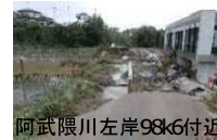
阿武隈川左岸98.6km付近
