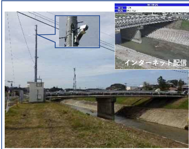
(設置例) 大谷川 城の下橋水位観測所
