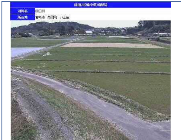
(設置例) 瓜田川 輪中堤 (内水監視)
