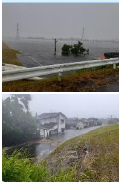
浸水被害の状況
