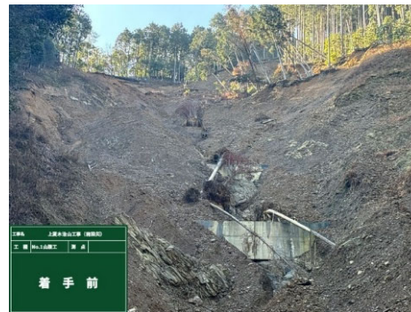
山腹崩壊地の復旧
