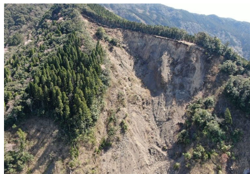
山腹崩壊地の復旧 R4
