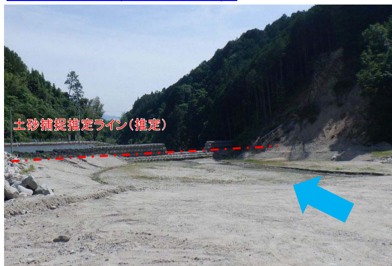
土砂捕捉前 (R2.6.2撮影)
