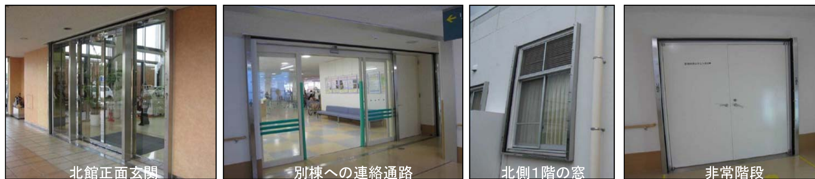
止水板のための角落としの設置
