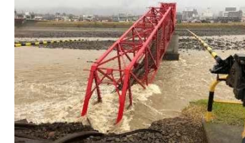
上田電鉄別所線(千曲川橋梁)
