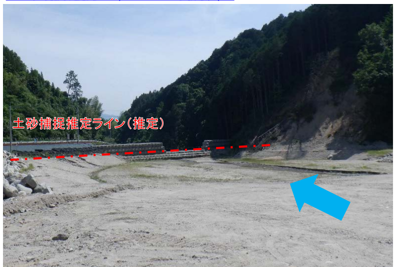
土砂捕捉前 (R2.6.2撮影)
