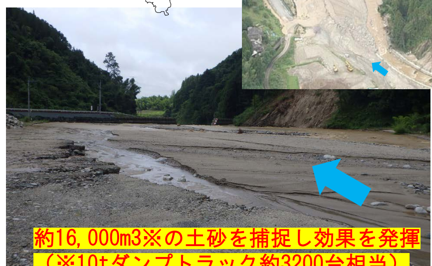
土砂捕捉後 (R2.7.8撮影)
