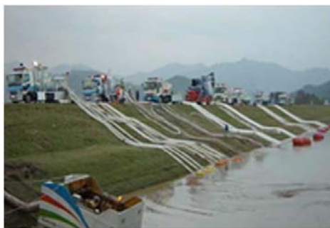
排水ポンプ車による緊急排水
