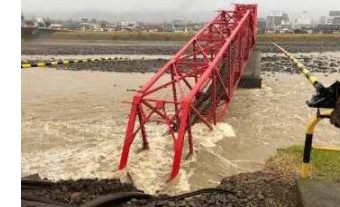
上田電鉄別所線(千曲川橋梁)
