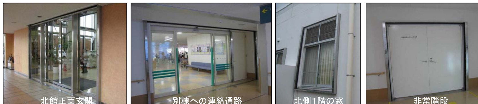
止水板のための角落としの設置
