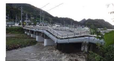
国道20号 山梨県大月市 法雲寺橋(橋梁下部工洗掘)
