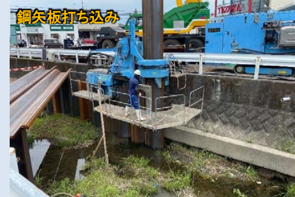
施工状況写真
