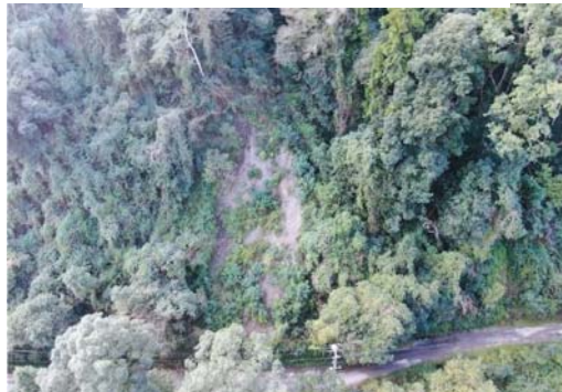
山腹崩壊地の復旧 R3
