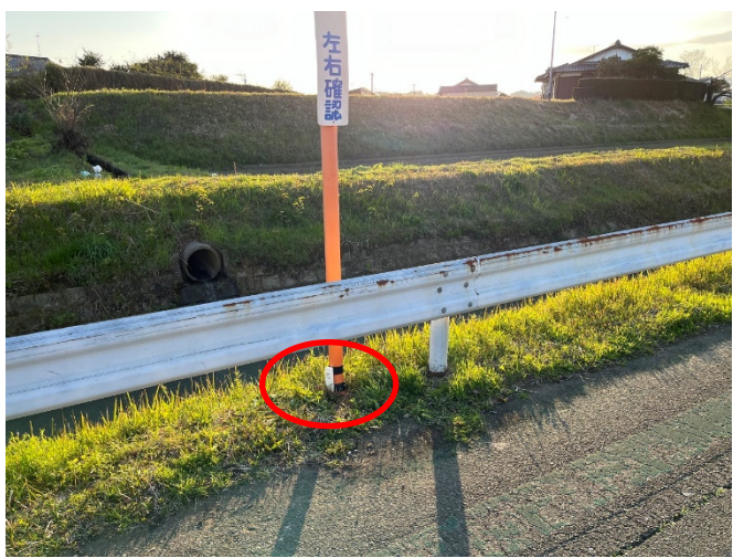
浸水センサ設置状況（木城町内）
