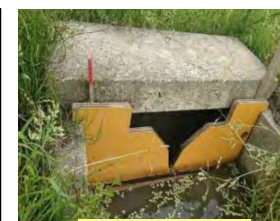
三角堰板の設置
