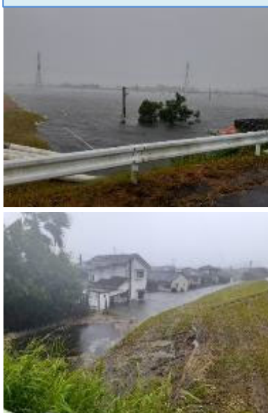
浸水被害の状況
