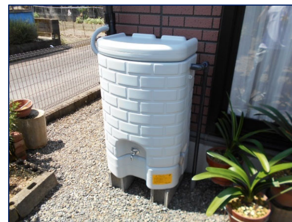
【雨水貯留施設設置例】
