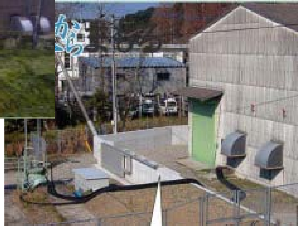
防水壁の設置(飯田川排水ポンプ場)
