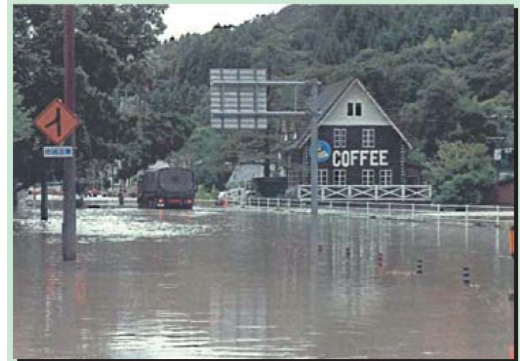
高岡町赤谷 国道10号 大淀川左岸 (26k000)
