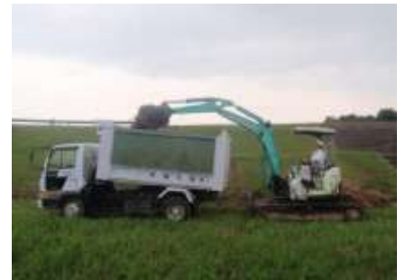
積み込み作業
