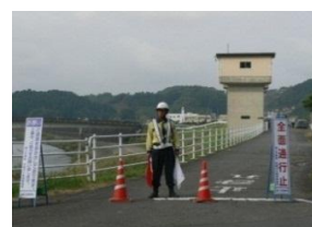
規制状況(通行止)
