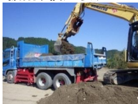
掘削、積込状況
