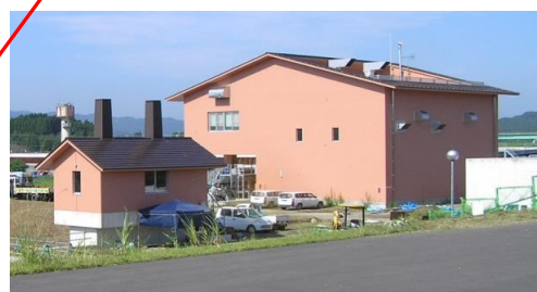
六田川排水機場 排水量 毎秒 3m 3
