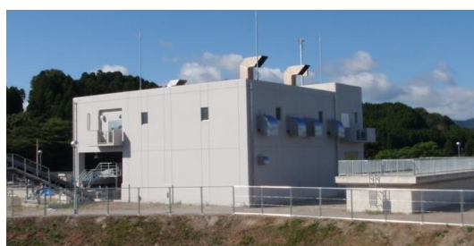
瓜田川排水機場 排水量 毎秒 20m 3
