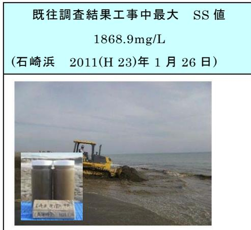
図－ 4.3 工事中最大濁度観測時の状況
