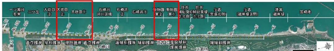
埋設護岸設置状況
