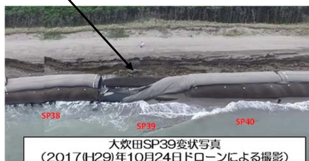
写真－ 2.4 海岸巡視等による埋設護岸等の施設の異常や浜崖侵食の有無の確認
