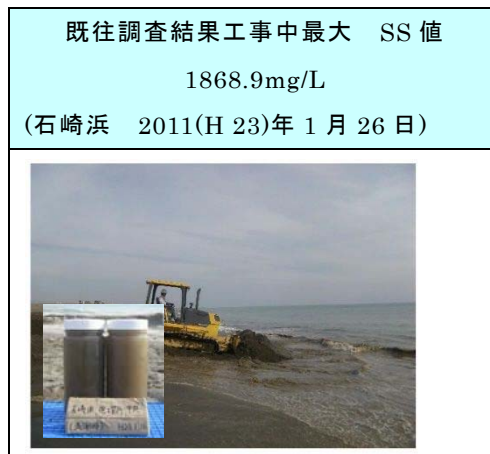
図－ 4.3 工事中最大濁度観測時の状況
