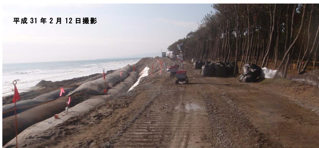
実施箇所状況
