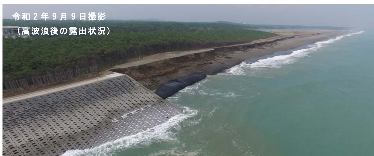
実施箇所状況
