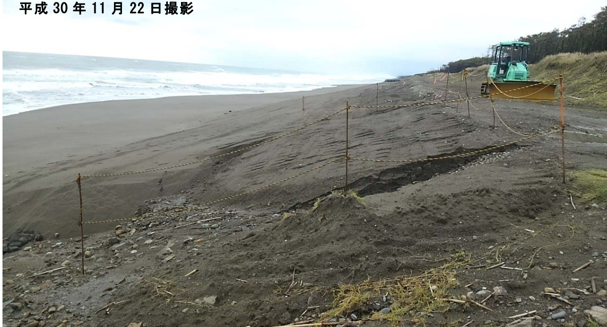
実施箇所状況
