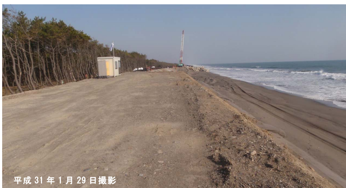
実施箇所状況
