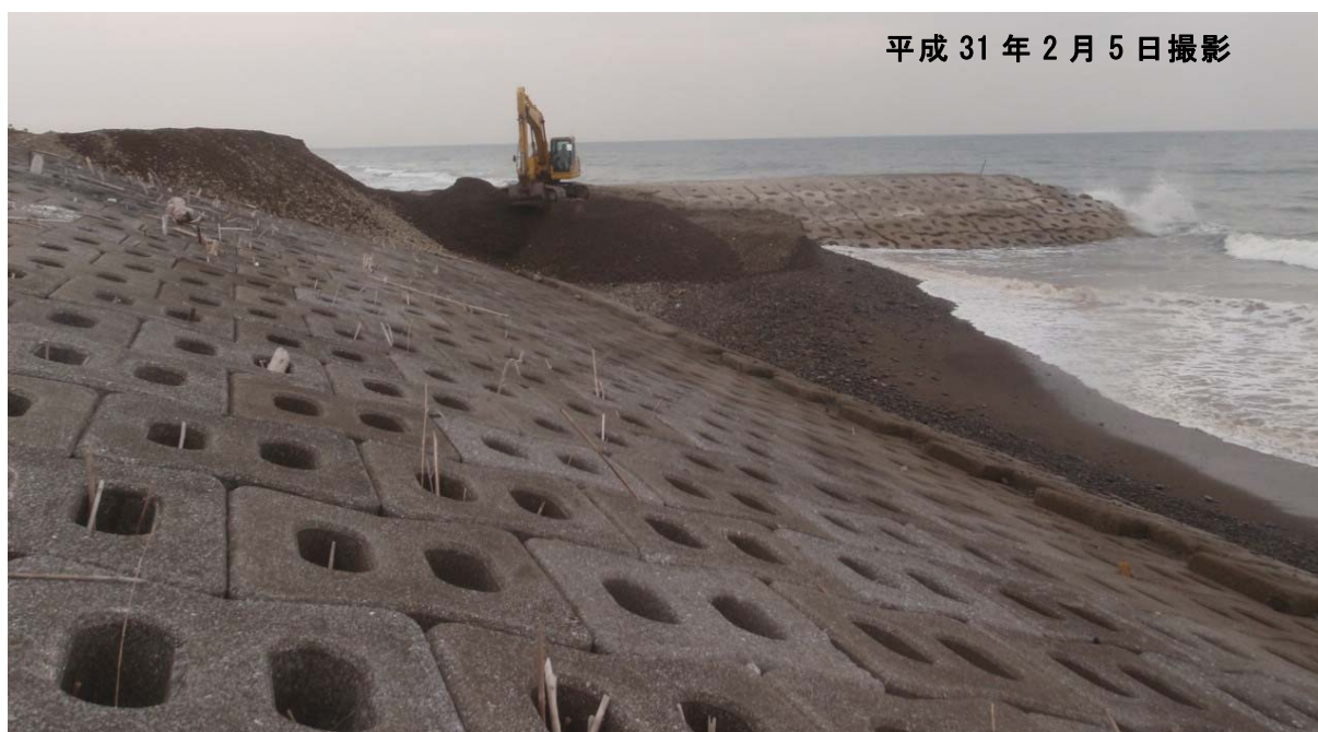
実施箇所状況
