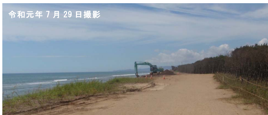
実施箇所状況
