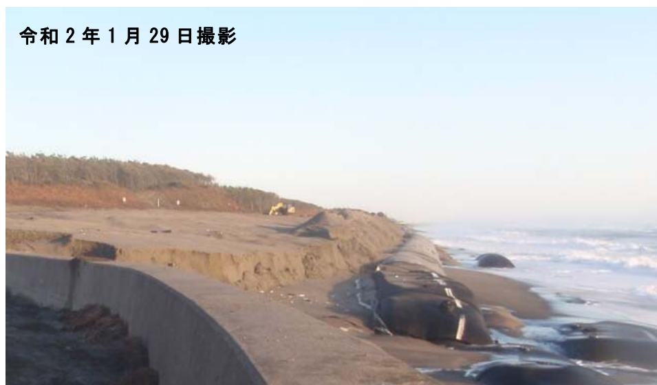
実施箇所状況
