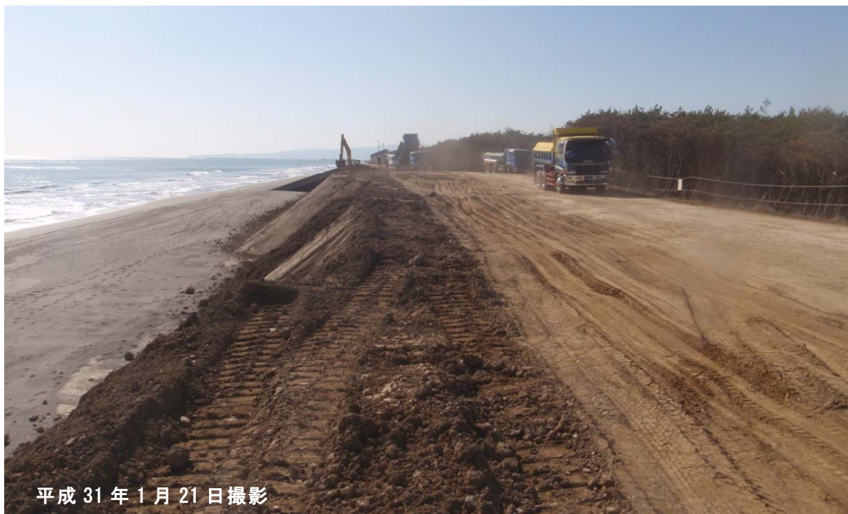
実施箇所状況
