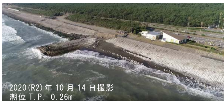
写真－ 3.3 2020(R2)年川砂利・川砂養浜投入後の補助突堤①周辺の様子
