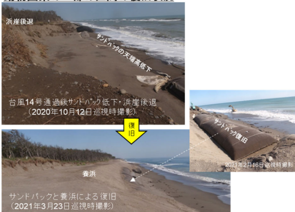
図－ 19 浜崖頂部高の変化および動物園東埋設護岸設置区間の浜崖形状の変化
