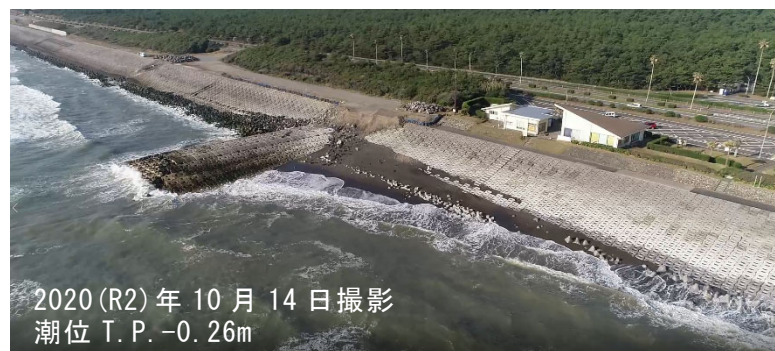
図－18 2020(R2)年の川砂利・川砂養浜投入後の補助突堤①周辺の様子
