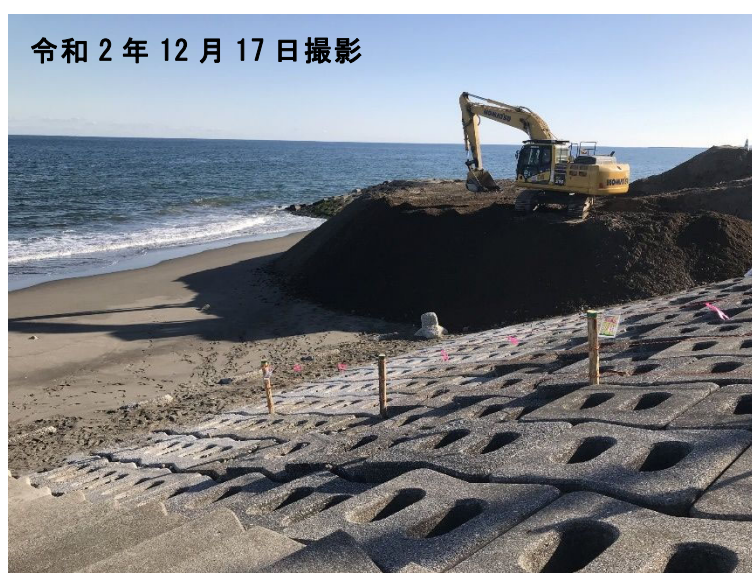
実施箇所状況
