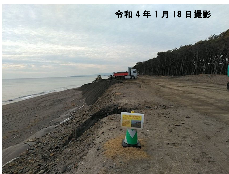
実施箇所状況
