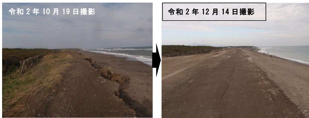
実施箇所状況
