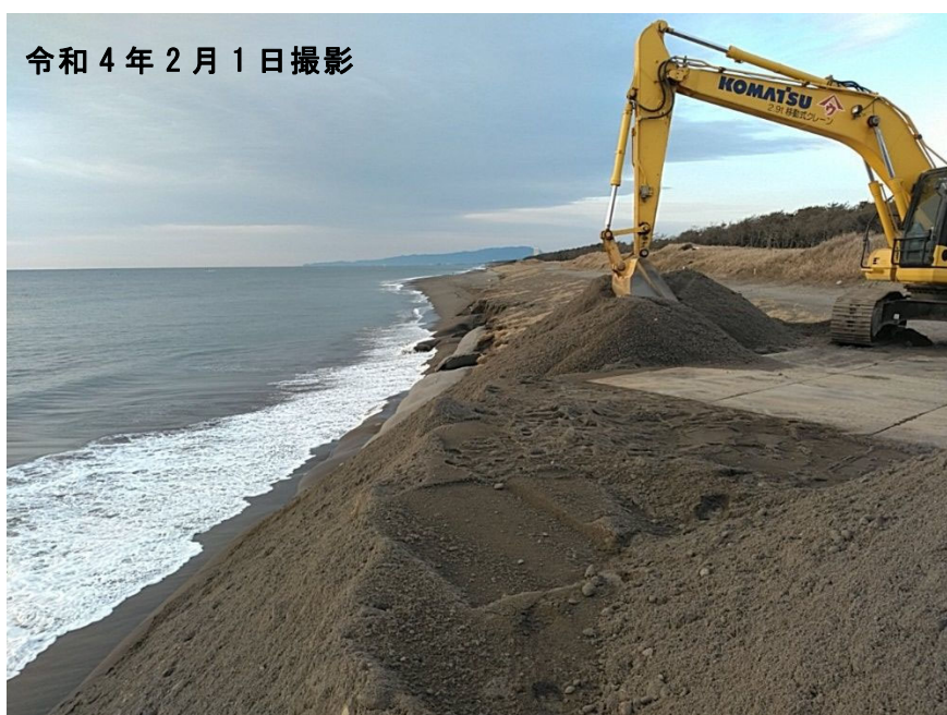
実施箇所状況
