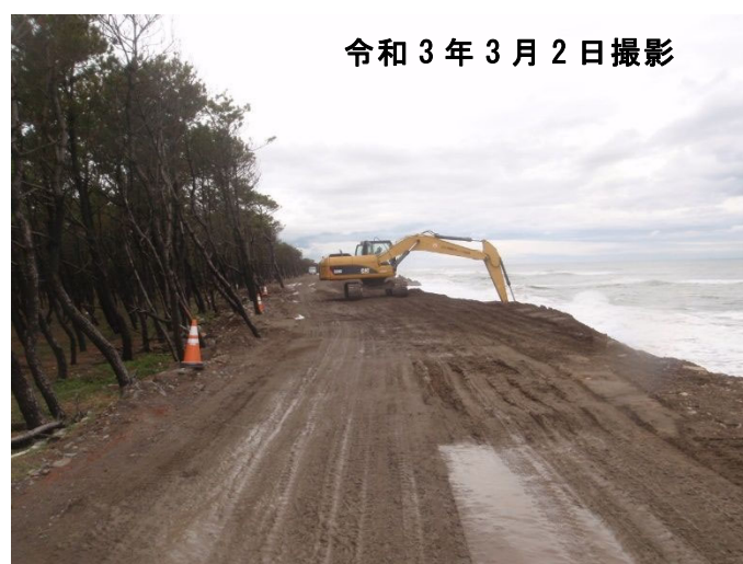
実施箇所状況
