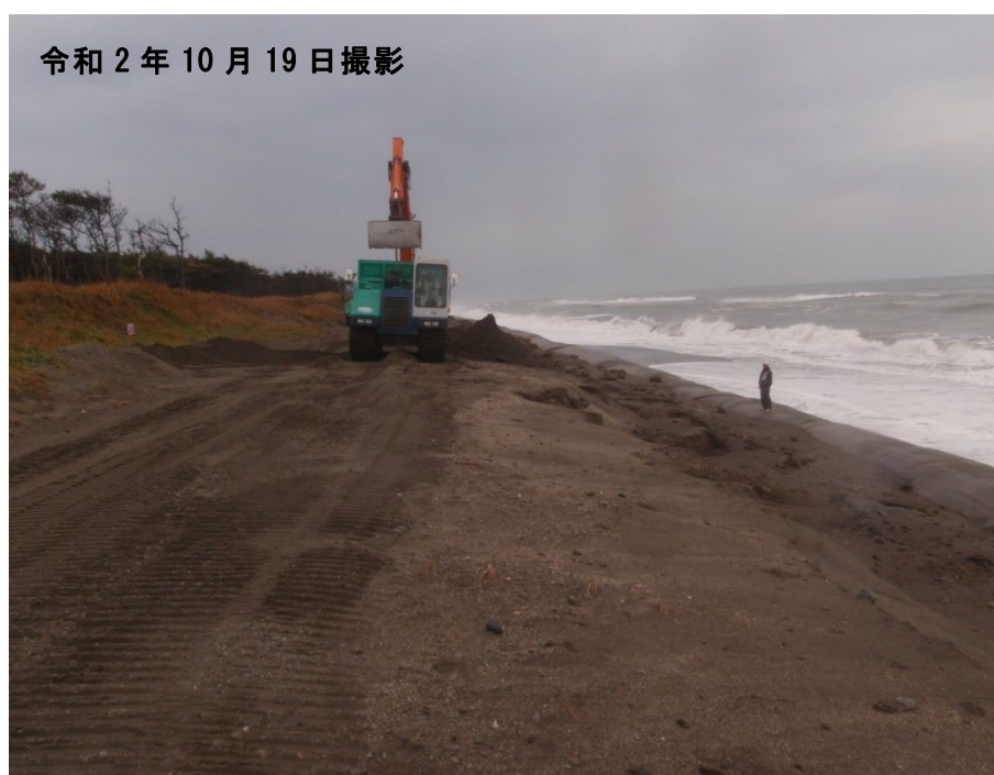
実施箇所状況
