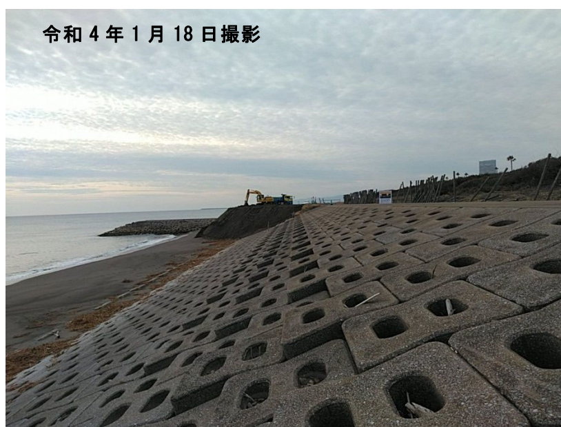
実施箇所状況
