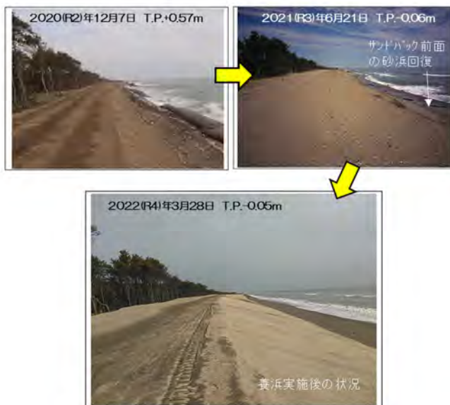
図- 3.16 浜崖頂部高の変化および動物園東埋設護岸設置区間の浜崖形状の変化
