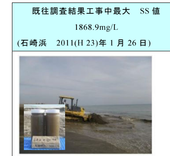
図－ 4.3 工事中最大濁度観測時の状況
