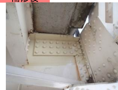
損傷(亀裂)箇所の補修
