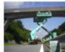
点検実施状況
