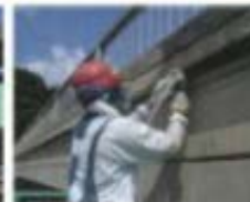
補修実施状況
