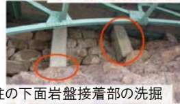
Co支柱の傾斜、下面岩盤接着部の洗掘
