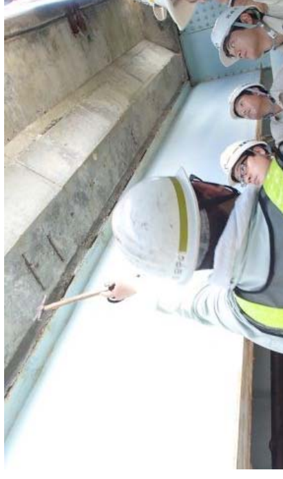
床版張り出し部 うき、剥離、鉄筋露出の状況確認
