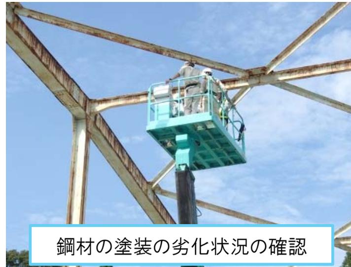
鋼材の塗装の劣化状況の確認
