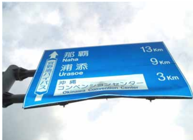
異常変形 (車両衝突)
