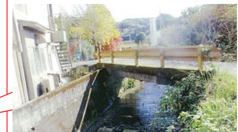
老朽橋の撤去
