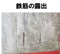
下部工にASRによる劣化が疑われる
