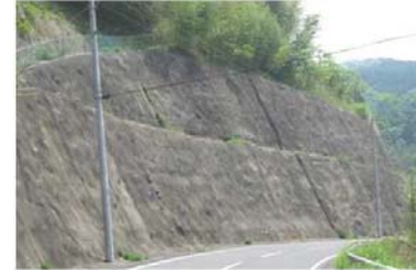
モルタル吹付
