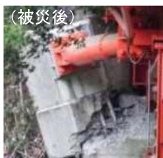
制震ダンパー取付部の損傷
