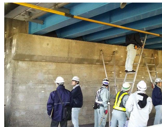
▲橋梁点検状況
