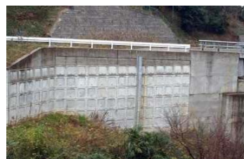
盛土(補強土壁)
