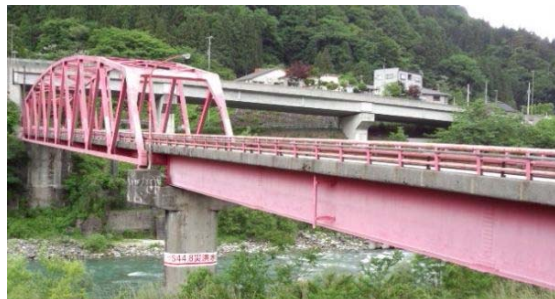
<音沢橋の状況>
