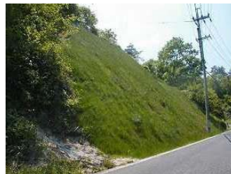
切土(法面保護)
