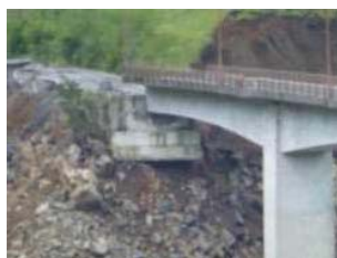
斜面変状による橋台の沈下
