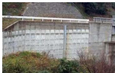
盛土（補強土壁）
