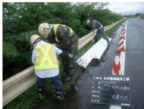
＜防護柵の取替＞
