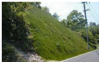
切土（のり面保護）
