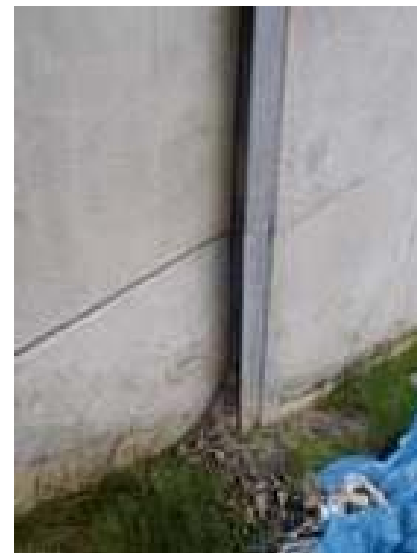
写真 土砂のこぼれ出し例
