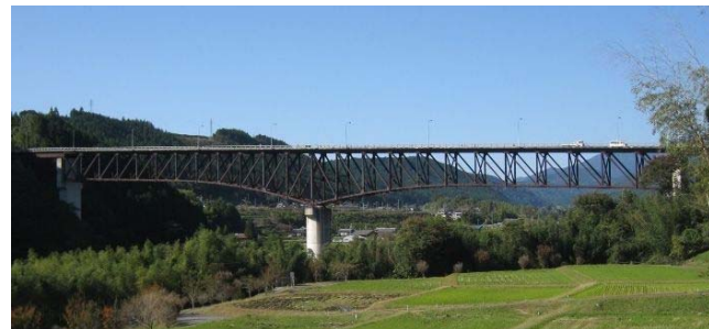
<乙姫大橋の状況>
