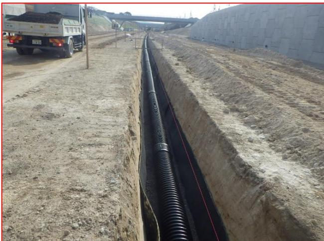
路床置換掘削完了状況
