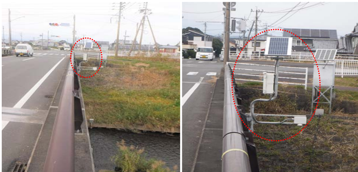
写真-7 内水観測用の水位計設置
