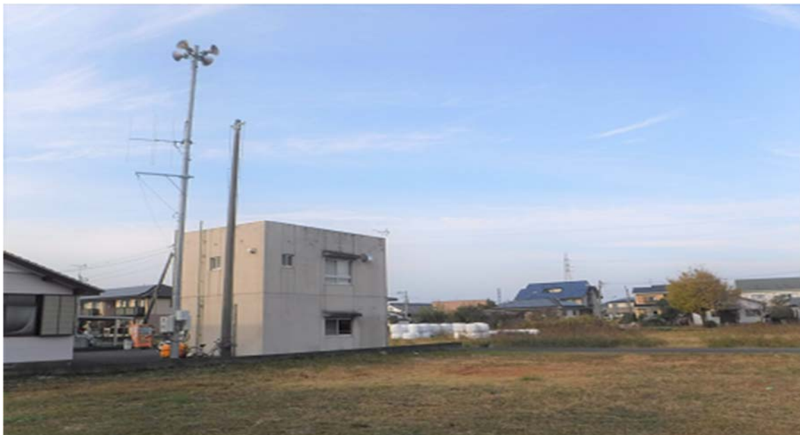
写真-8 町内一円カバーする防災行政無線整備（高鍋町）
