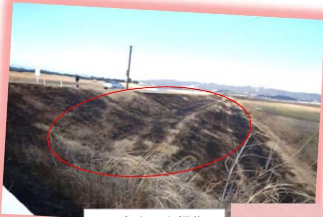
堤防法面を損傷
