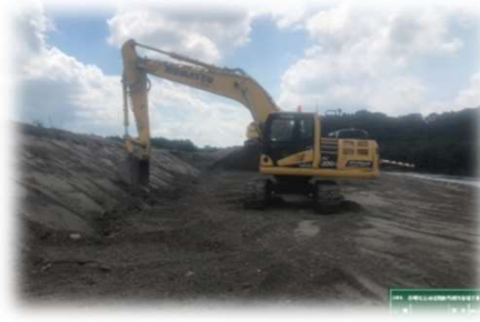
ICTによる河道掘削
