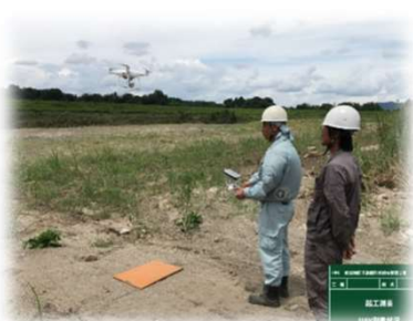
UAV測量(起工・出来形)
