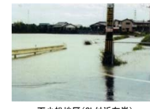
下小松地区(8k付近右岸)の浸水状況
