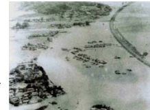
右岸大塚町(6k)付近の浸水状況(宮崎市)
