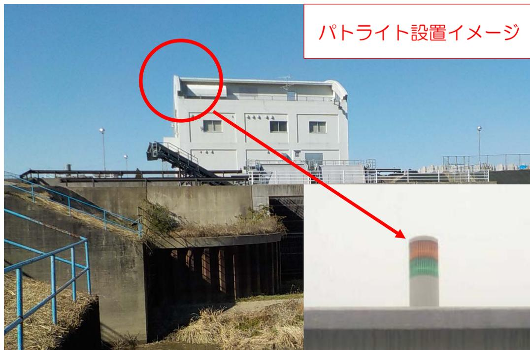
排水機場への操作員の到着・待機、ポンプ稼働・停止時にパトライトで点灯・消灯で状況を把握。
