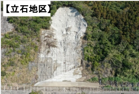
モルタル吹付
